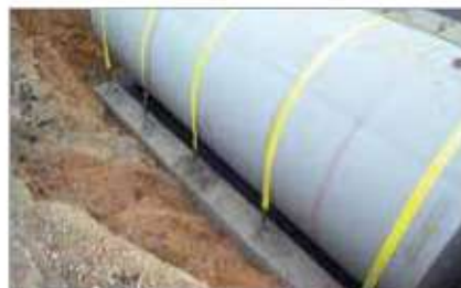
Lavaggi di serbatoi interrati
