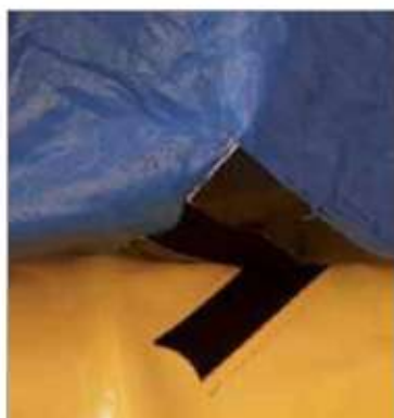
Particolare del fissaggio tra vasca e liner.
