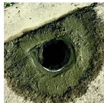
**alloggiare e fissare la base in gomma con malta cementizia**
